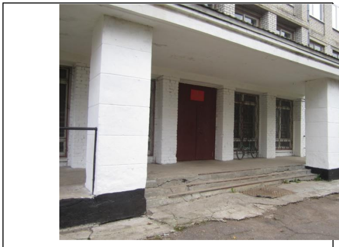
фото 3 Входная лестница, навес
