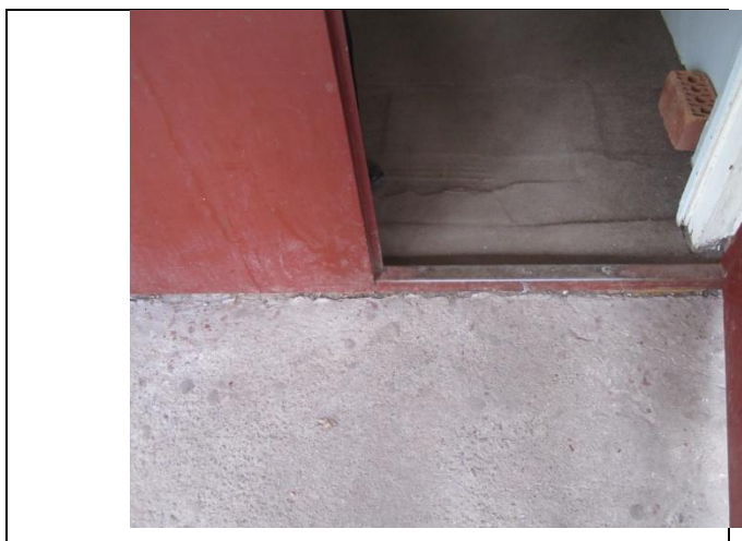
фото 5 Входная наружная дверь
